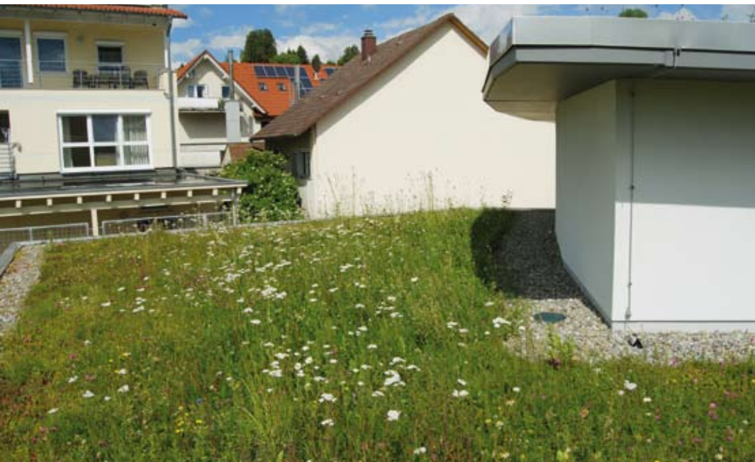
Foto 2 Regenschatten Kiesstreifen bei Regenschatten durch überstehende Dächer
