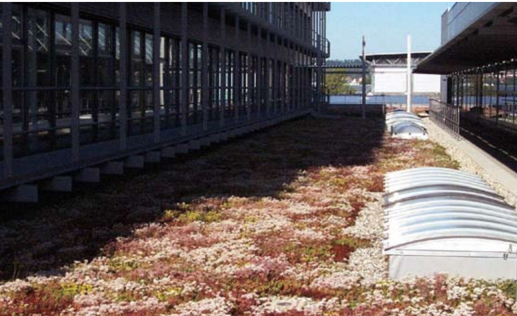
Foto 1 Licht + Schatten Verschattete Extensivbegrünungen neigen zur Vermoosung
