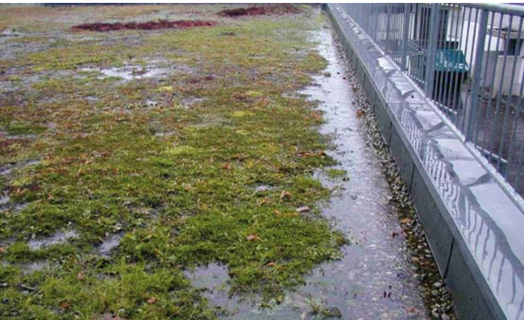
Foto 2 Nicht ausreichend funktionsfähige Drainage: stehendes Wasser in der Fläche.
