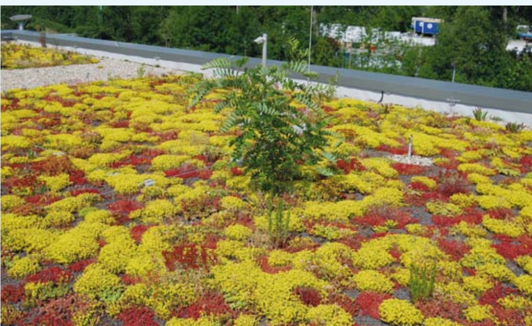
Foto 1 Die Fertigstellungspflege gehört zur Bauabwicklung einer Dachbegrünung
