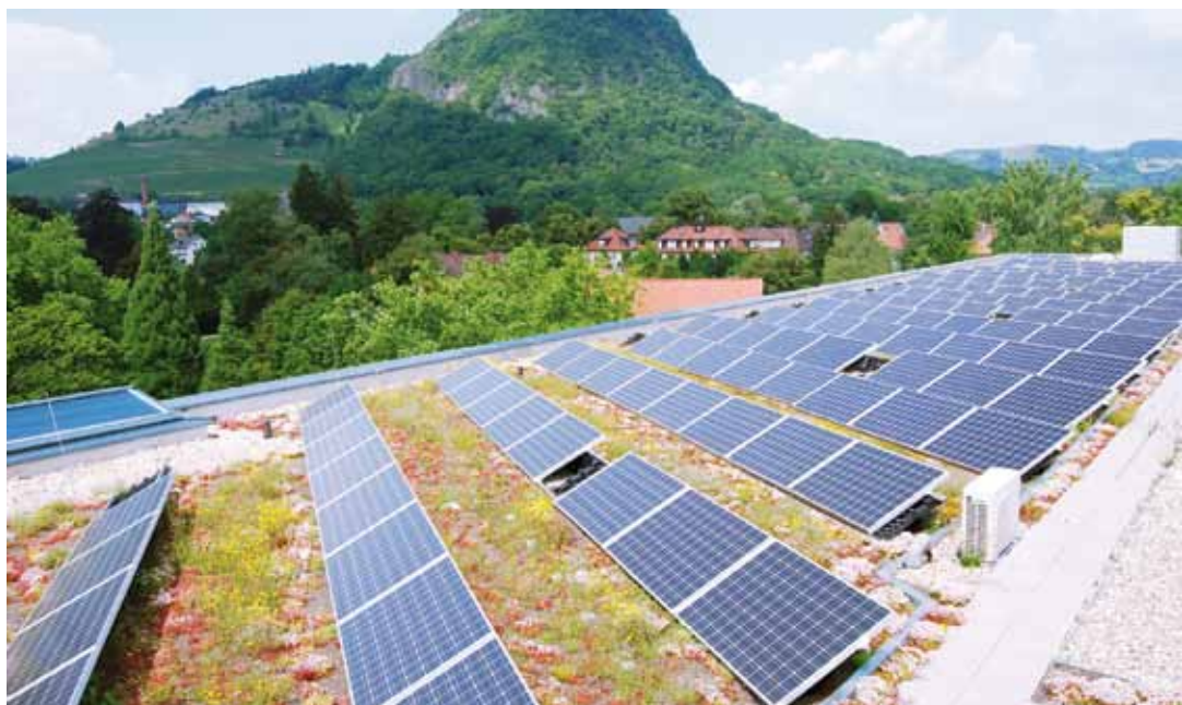
Die Kombination Photovoltaik / Dachbe- grünung ist aufeinander abzustimmen: „SolarGrünDach“
